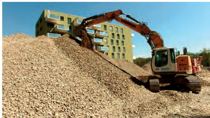
*Tri et concassage des graviers issus du site pour la construction de la route de Challex.*
