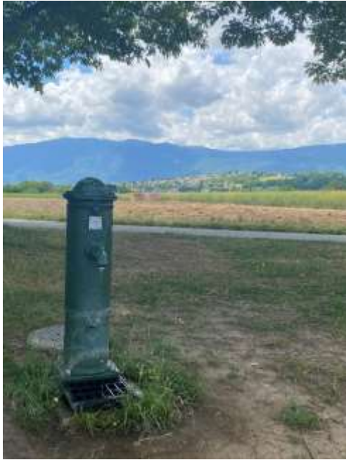
Fontaine de « purge »
